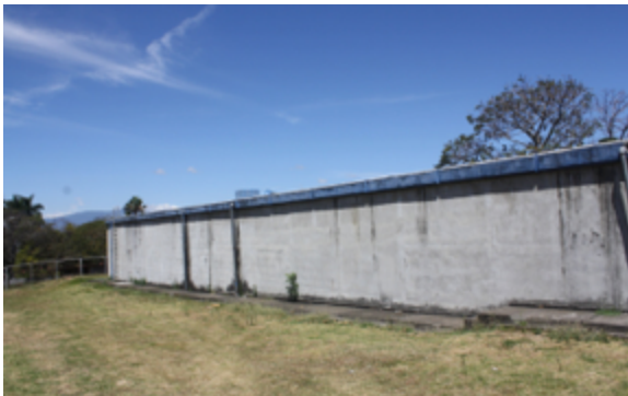
Figura 7 Otra vista lateral del tanque de concreto Cementerio Escazú. Nótese las trazas dejadas por filtraciones en la pared.
