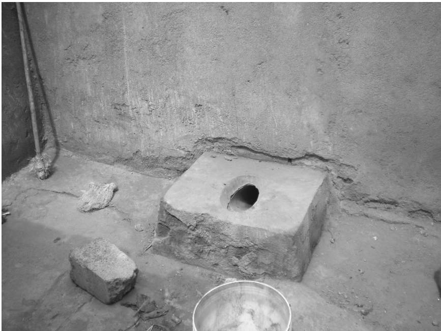
Figure 5.3 Traditional pour flush toilet
