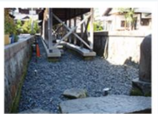
井戸枯れが発生
