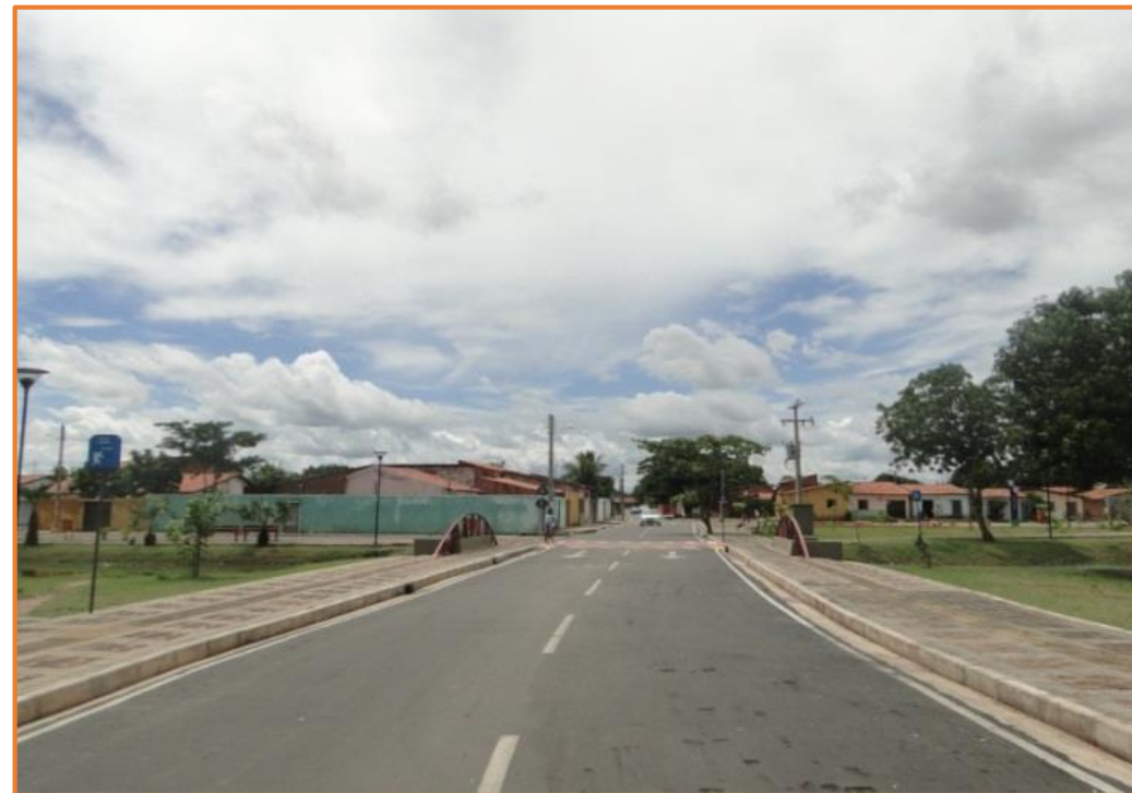
Depois da intervenção
