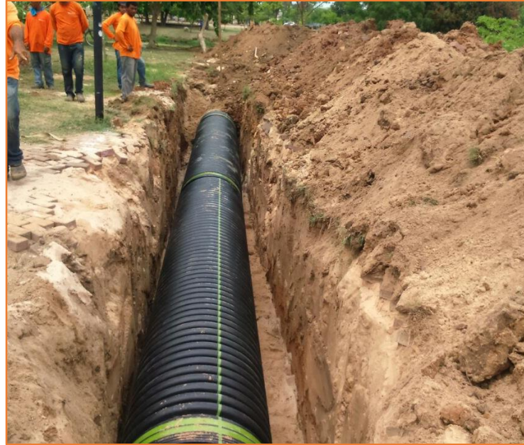
Obra em andamento
