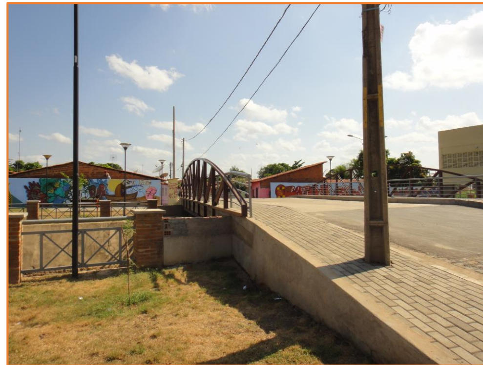
Depois da intervenção
