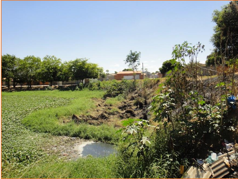
Situação antes da intervenção
