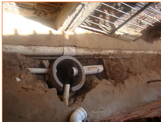
Obra em execução
