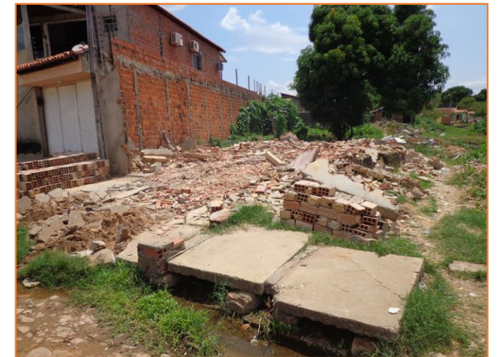
Obra em execução
