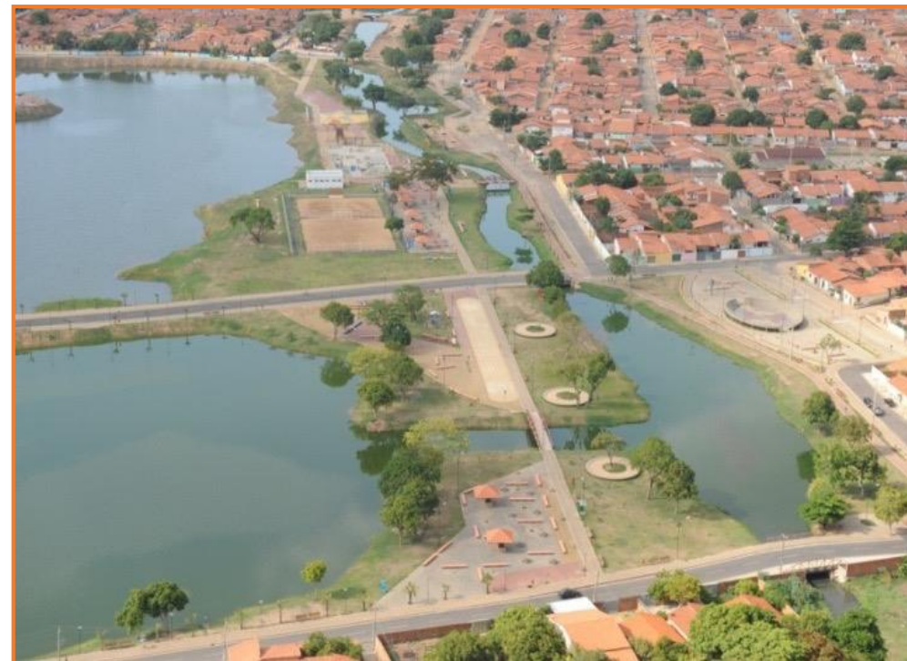
Depois da intervenção
